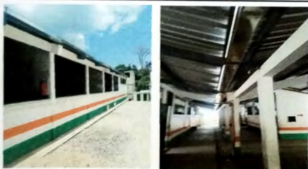
Foto 9: Vista de Canal de metal en Modulo A parte posterior aledaña a cancha de basket ball y lado frontal .
