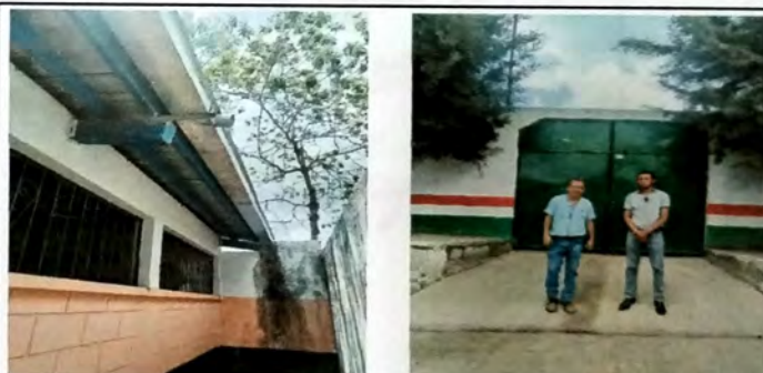
Foto 10: Vista modulo G instalacion de canal de metal con pescantes de metal. Vista de ingreso al centro escolar.
