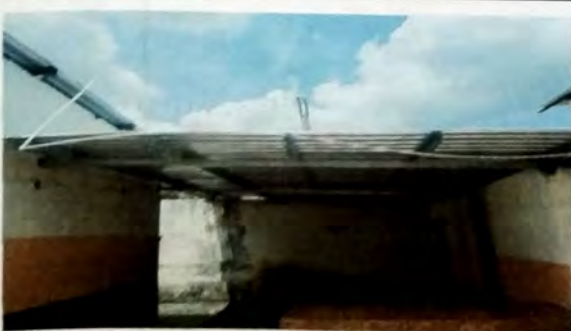
Foto 11: Vista modulo de cocina susitucion de estructura de metal en mal estado por estructura de metal nueva, se sutituyo lamina de zin se instalo lamina troquelada cal 26.
