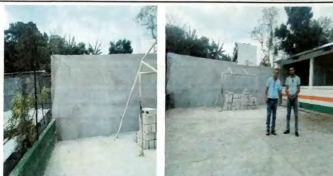
Foto 8: Sustitucion de muro de block desplomado, por muro de block reforzado desde sus cimentacion.
