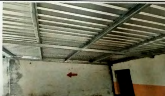
Foto 12: Vista de cubierta de Cocina con estructura de metal nueva e instalacion de lamina troquelada cal 26.
