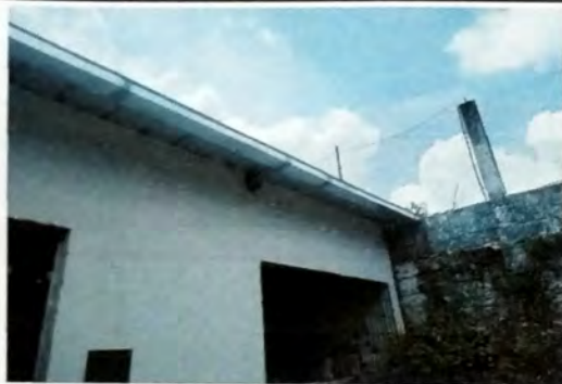
Foto 7: .Modulo D instalacion de canal de metal con sus pescantes.
